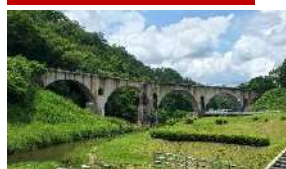
めがね橋と 道の駅みやもり
